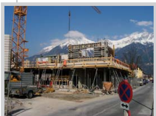
März 2007 | Die ersten Baufortschritte am neuen TBSZ sind zu sehen.
