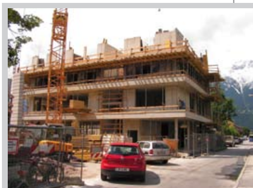
Mai 2007 | Zwei Stockwerke sind bereits fertiggestellt.
