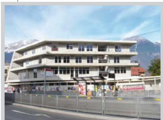
Oktober 2007 | Das neue TBSV-Gebäude erhält Fenster.
